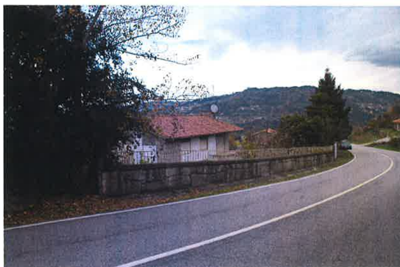
Estrada da barragem
