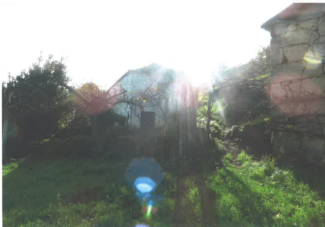
Terreno onde será implantada a moradia, palheiro a demolir e moradia a Sul.
